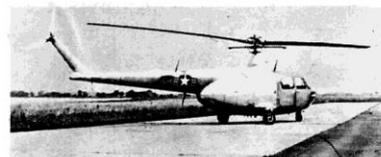
**BELL Mod. 48, H-12** — Derivato per ingrandimento dal mod. 47, costruito nel 1947 (XH-12) e 1949 (YH-12B). Ha undici posti ed è adatto a impieghi diversi (come ambulanza porta 6 barelle). Motore P&W. «Wasp» da 600 cv.. Diam. rot. 14,48 m.; peso tot. 3000 kg.; vel. mar. 168 kmh.; raggio d'az. 640 km..
